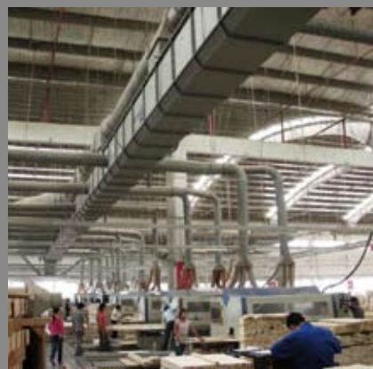
Moldow的管道系统更加灵活的改变了生产的布局
