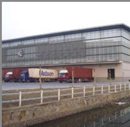
台升的大量全自动仓库综合楼
